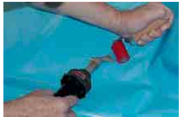
Reparando una cubierta de piscina con HOT-JET S.
