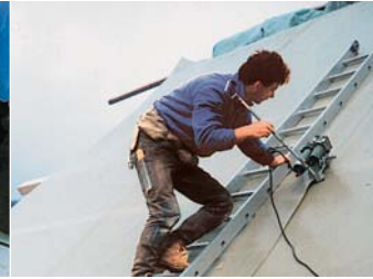
X84 al soldar una lámina de a cubierta en un techo de gran inclinación. Gracias a sus escasos 6,1 Kg, X84 afronta cualquier inclinación con una velocidad constante.
