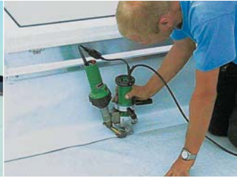
TRIAN DRIVE PID al soldar lámina sintética impermeable en torno a una cúpula transparente.
