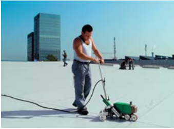
VARIMAT V al soldar a solapa láminas sintéticas de impermeabilización.
