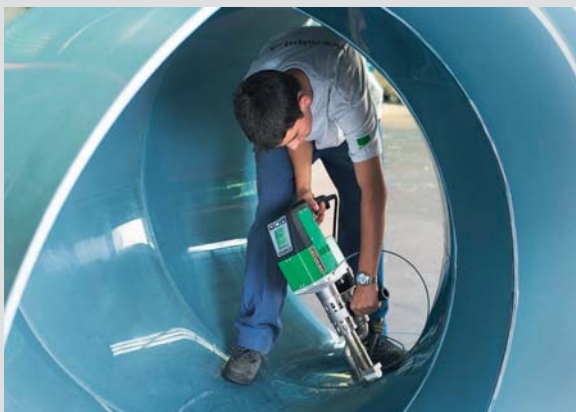
Construcción de tubos con WELDPLAST EC4
