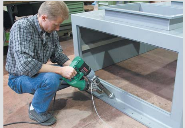
Reparaciones con FUSION 3C
