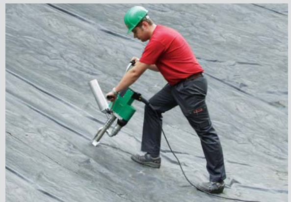
Construcción de balsas con WELDPLAST G6 (con depósito de granza)
